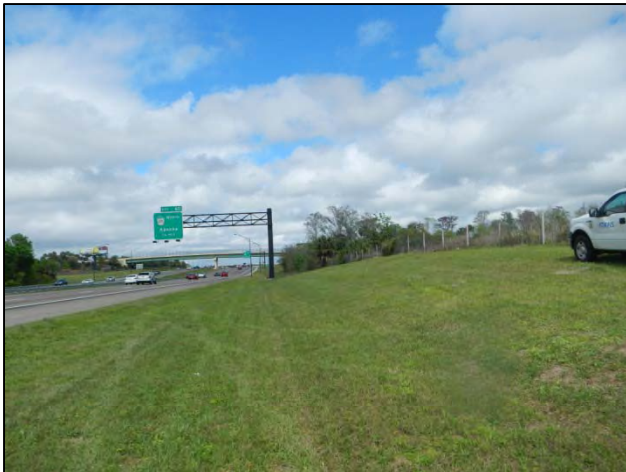
Area 7 facing NE
