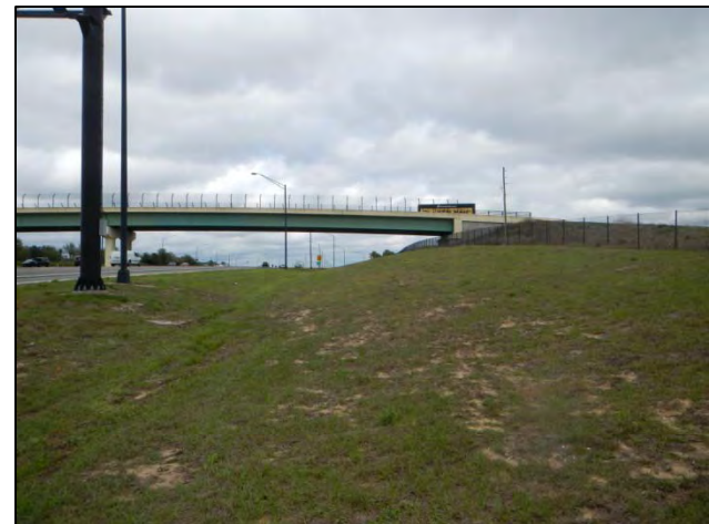
Area 7 facing NE
